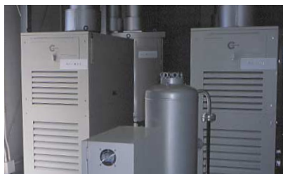
沖縄県初の設置となったマイクロタービン発電機
