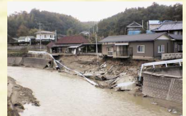
台風23号による川岸決壊現場(香川県高松市)
