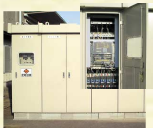
[写真2] 高速無効電力抑制器(フリッカー対策器)
