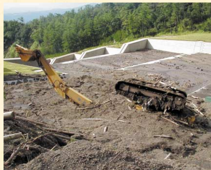
土石流に埋まった業者保有の油圧ショベル(鹿児島県桜島地区)
