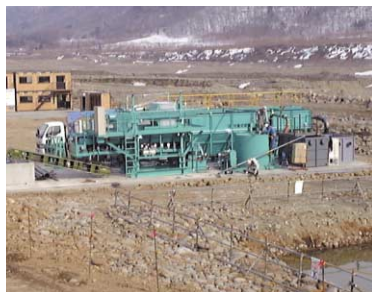
発電所の移設工事で活躍する同社の濁水処理プラント。手前は濁水を貯める調整池
