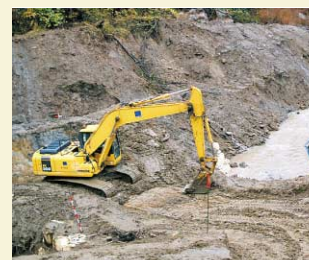
新潟中越地震の災害復旧工事で稼働する当社建機
