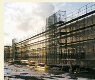
(株)エスアールジー・カナモトの仮設足場
