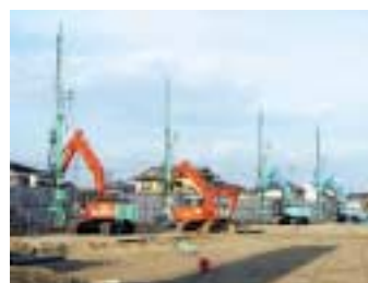
佐賀県の導水管工事現場で活躍する同社の地盤改良機械
