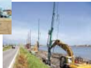
筑後川での地すべり抑止地盤改良工事現場の様子
