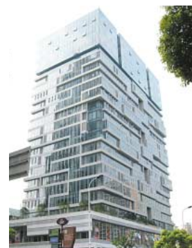
新たに移転した本社のオフィスビル
