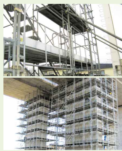
橋梁の耐震補強工事現場で使われる軽量仮設足場資材
