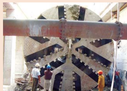
中国ではシールド掘進機や連壁マシンのほか、高所作業用機械、仮設ユニットハウスなどもレンタル
