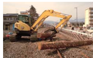
津波による被害を受けた大船渡営業所近郊で復興工事に使用される当社建機
