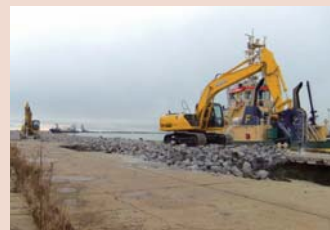
今夏以降、港湾などのインフラ復旧工事がさらに本格化する見込み。写真はいわき港湾で使用されている当社建機
