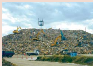
岩手県石巻市で瓦礫処理を行う当社建機
