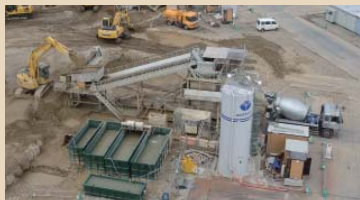
仙台市内の地盤改良工事（流動化処理）の現場
