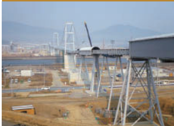
岩手県陸前高田市の高台造成工事で発生する土砂の運搬に活躍する巨大ベルトコンベア
