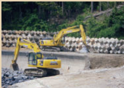
宮城県南三陸町の 防波堤復旧工事
