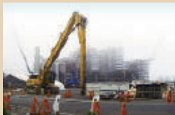
宮城県石巻市の瓦礫解体工事
