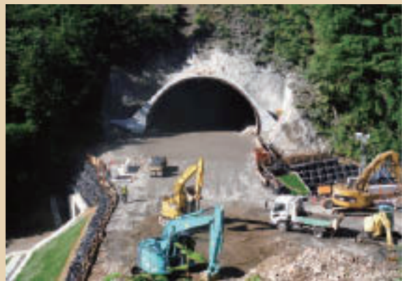
岩手県宮古市の 三陸沿岸道路45号トンネル工事
