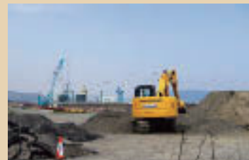
宮城県石巻市の防潮堤工事
