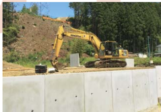
宮城県気仙沼市の防災集団移転造成工事
