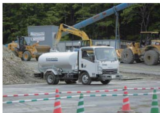
岩手県宮古市の新区界トンネル工事
