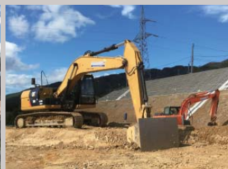
岩手県陸前高田市の高台造成工事
