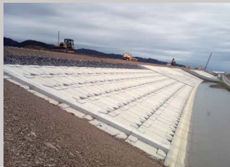
宮城県石巻市の北上川長面築堤工事
