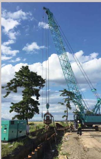
宮城県岩沼市の五間堀川河川災害復旧工事
