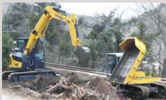
宮城県伊具郡丸森町のJRあぶくま駅災害復旧工事
