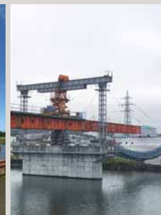
宮城県気仙沼市の曙橋新設工事
