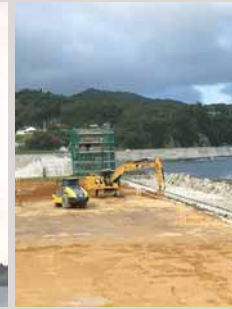
宮城県石巻市の防潮堤工事
