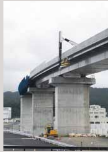
宮城県気仙沼市の気仙沼湾横断橋工事
