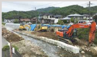
広島市安芸区の瀬野川災害復旧工事
