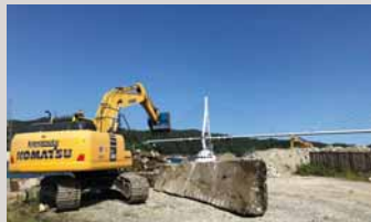
宮城県気仙沼市の一景島地区盛土嵩上げ工事
