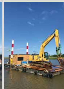
宮城県岩沼市の中貞山河川災害復旧工事
