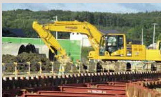
北海道勇払郡厚真町の厚幌導水路宇陸下流工区災害復旧工事
