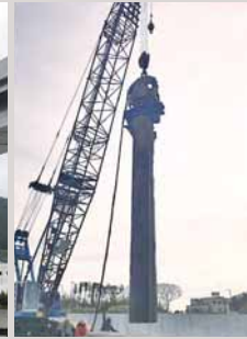
宮城県気仙沼市の朝日町赤岩港線橋梁下部工工事
