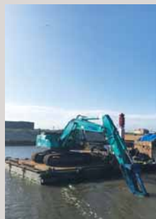
宮城県岩沼市の五間堀河川災害復旧工事
