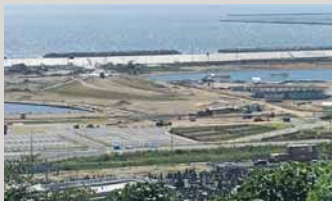
宮城県石巻市の復興祈念公園整備工事
