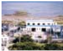
町田機工本社
