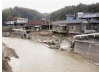
台風23号による川岸決壊現場(香川県高松市)
