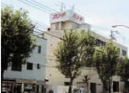
カンキ本社ビル 神戸市須磨区
