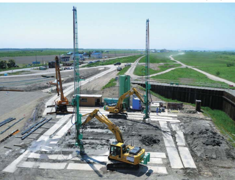
軟弱地盤を改良するMITS工法 MITS method for improving soft ground
