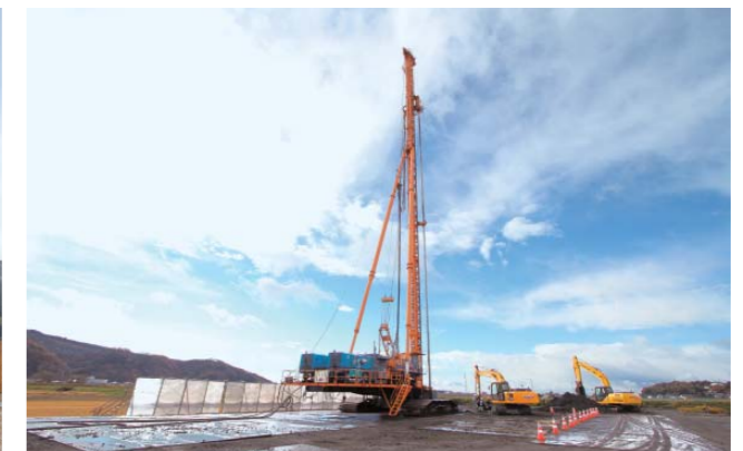
大瓜道路（宮城県石巻市）の改良工事 Ouri Road improvement works (Ishinomaki, Miyagi Prefecture)
