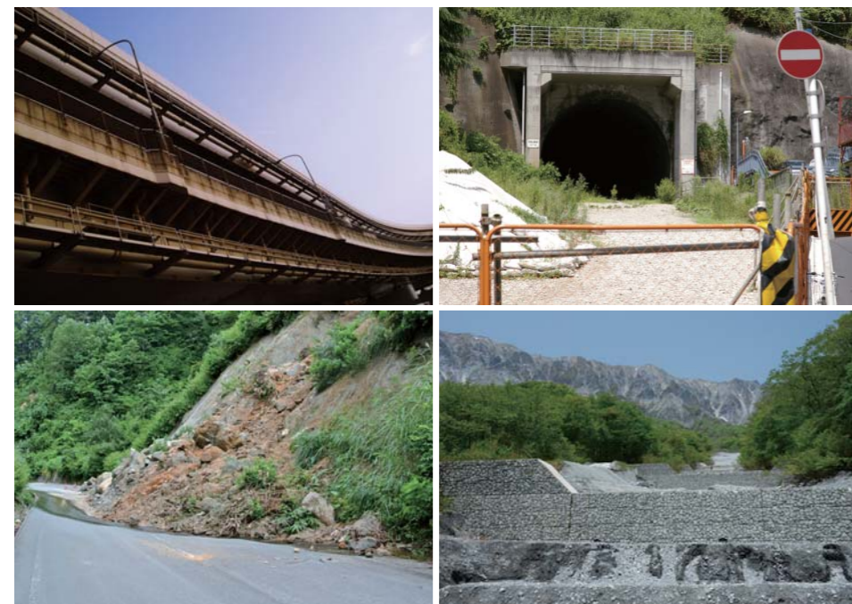
2012年に開通から50年を迎えた首都高速道路、トンネルなど多くのインフラが更新時期を迎えています
