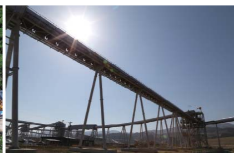
岩手県陸前高田市の高台造成工事で、発生する土砂の運搬に使用する巨大ベルトコンベア Enormous belt conveyer used to transport soil produced during elevated land construction works at Rikuzentakata City in Iwate Prefecture
