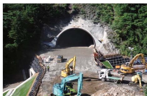
岩手県宮古市の三陸沿岸道路45号トンネル工事 Construction work on Sanriku Coastal Road Tunnel 45 in Miyako City, Iwate Prefecture
