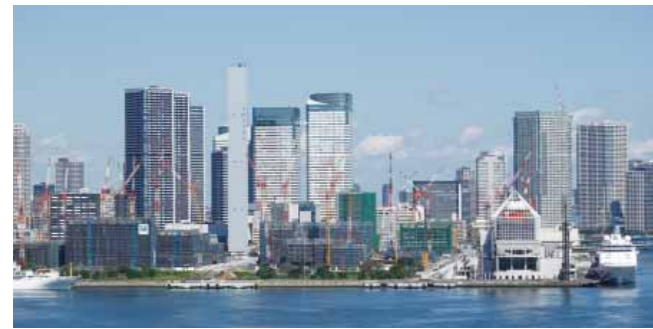
東京五輪関連工事の現場（臨海部） Site of Tokyo Olympics-related works (waterfront area)
