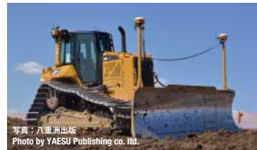
3DMCや3DMGを使った情報化施工 Information-aided construction using 3DMC and 3DMG
