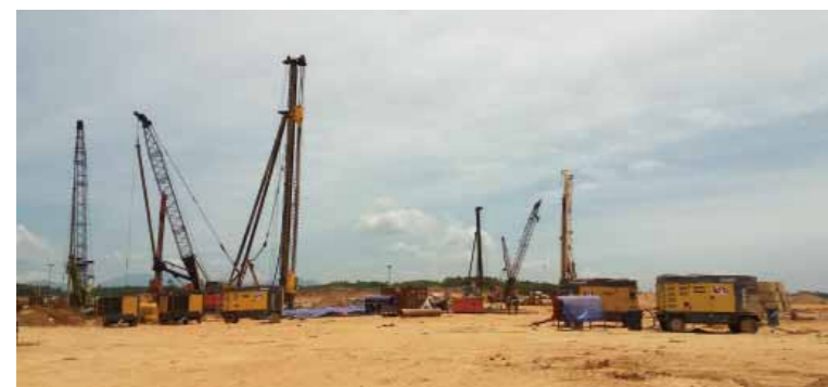
ベトナムの工事現場で使用される当社建機 Kanamoto construction equipment being used at worksites in Vietnam
