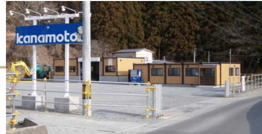
2012/1/20岩手県 釜石営業所
